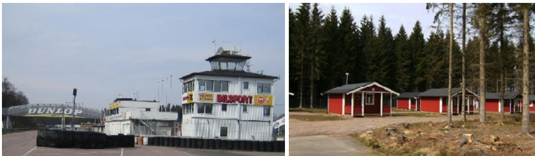
Befintlig bebyggelse vid motorbanan samt tillhörande stugby.
